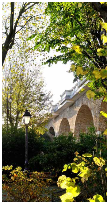
Viaduc des Arcades
